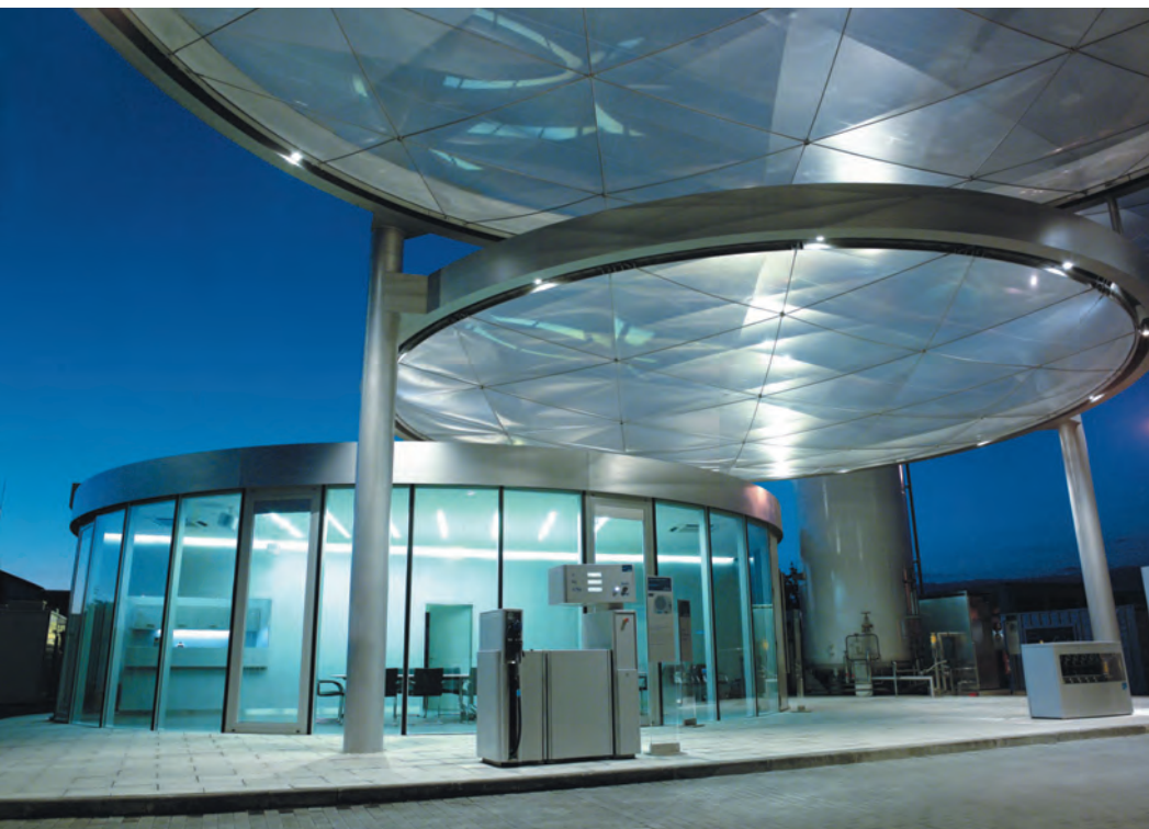
Le projet de station à hydrogène vert ouvert récemment par les norvégiens de Linde à Munich.
